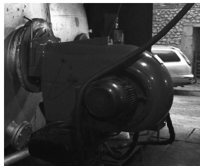
Слика 4.5. Горионик топловодног котла
