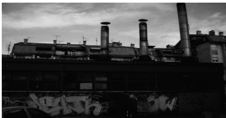
Слика 4.10. Котларница Папазовац
