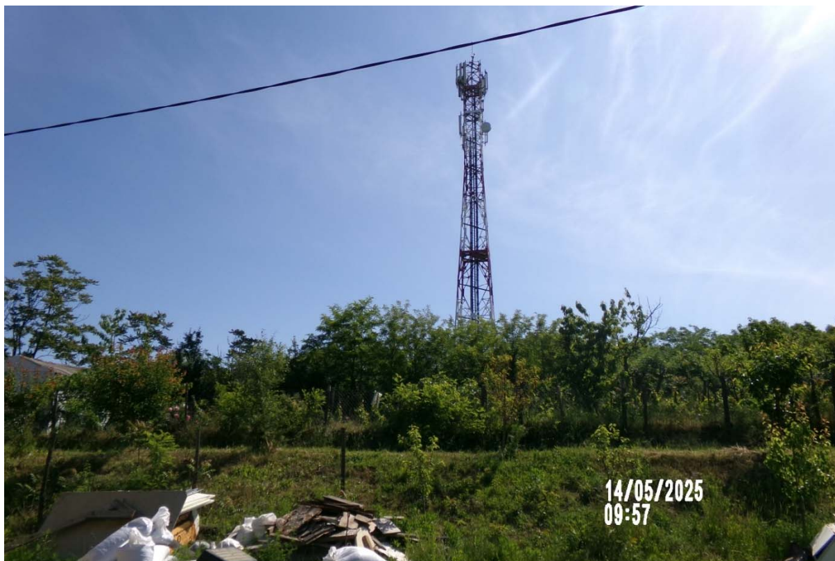
Slika 2.4 Prikaz antenskog stuba na lokaciji bazne stanice
