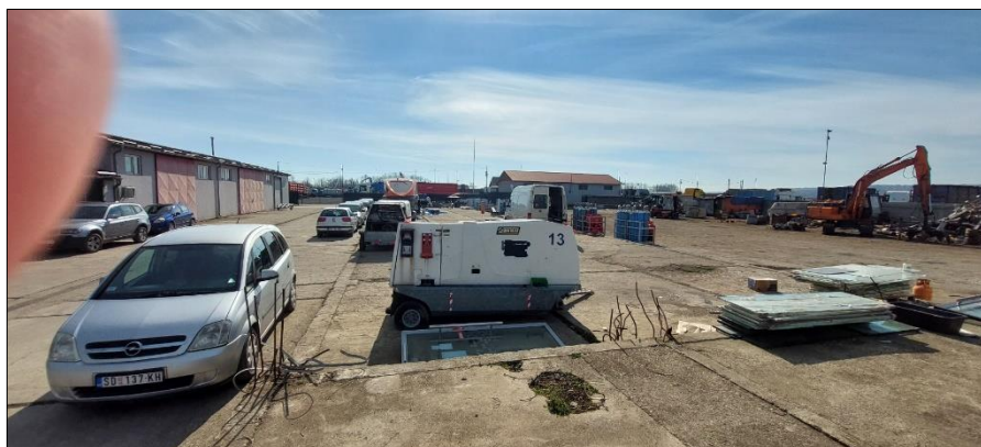
Slika 4 Otvorene pripremljene površine na lokaciji projekta
