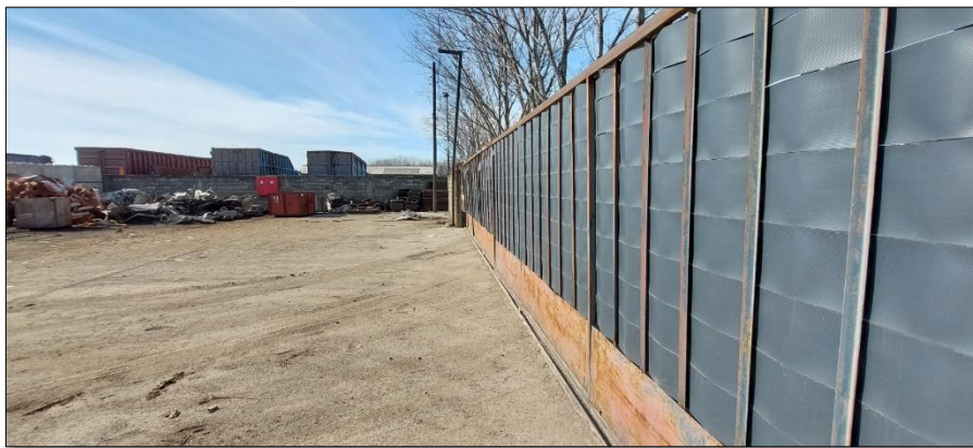
Slika 5 Ograda kompleksa na lokaciji projekta
