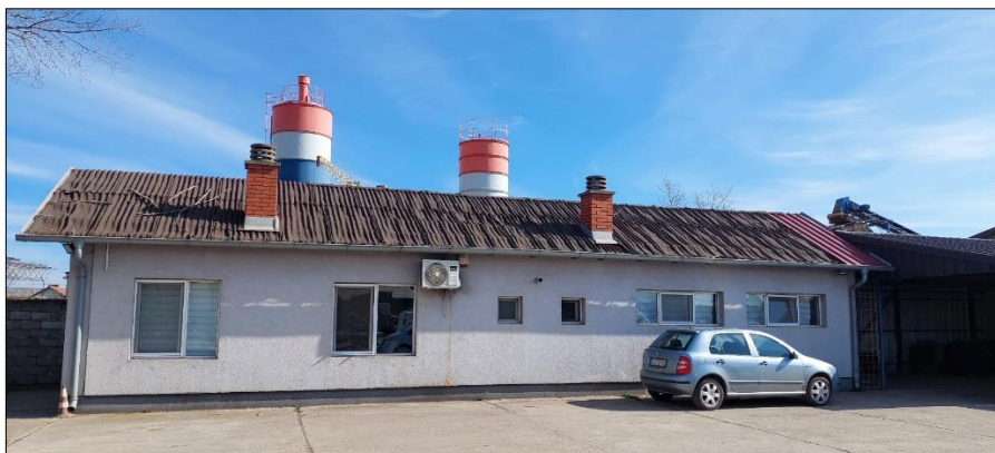
Slika 2 Administrativni objekat na lokaciji projekta
