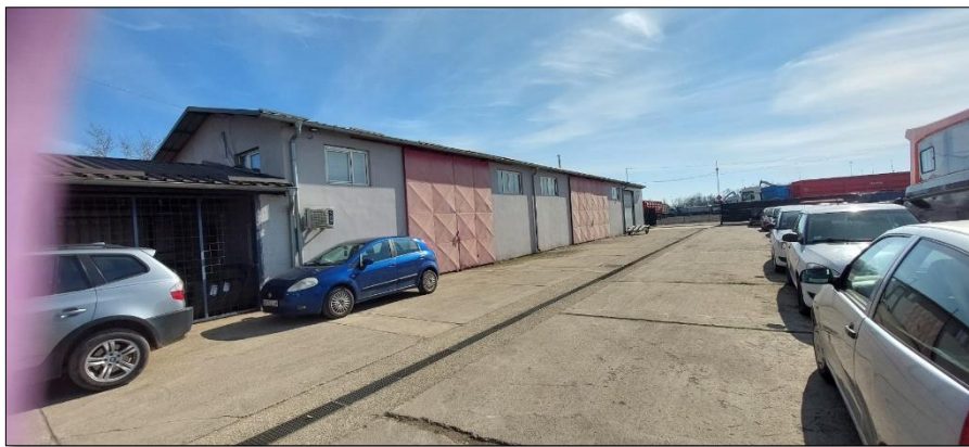
Slika 3 Objekat hale na lokaciji projekta, sa ulazom u postrojenje
