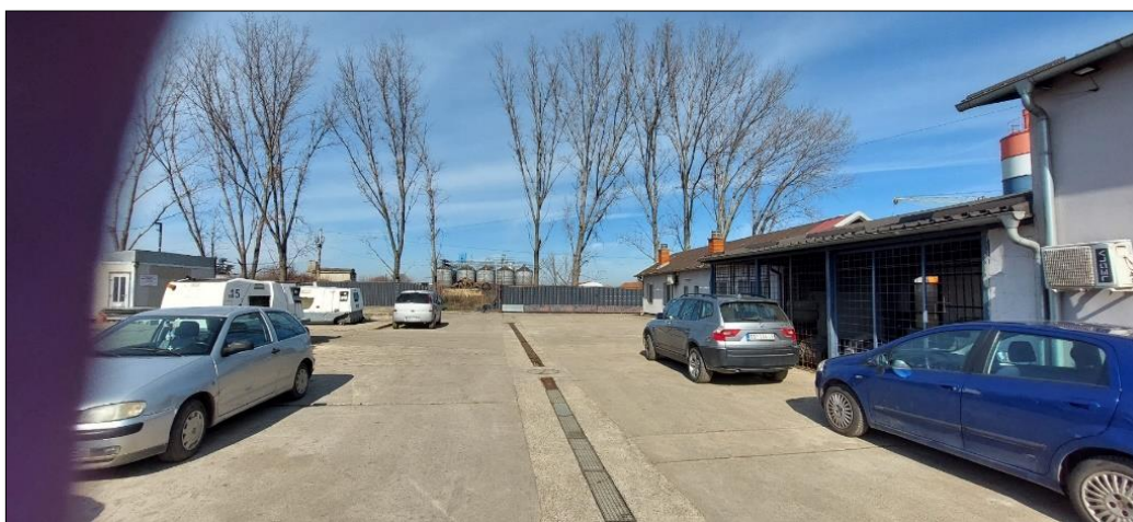
Slika 8 Rigole (kanalice) na lokaciji projekta, za prihvat atmosferskih voda ka separatoru
